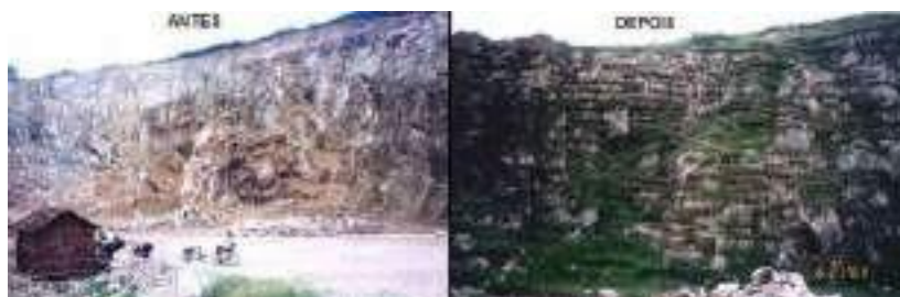
Figura 2 – Uso do vetiver para estabilização e revegetação de taludes de uma pedreira na China.
